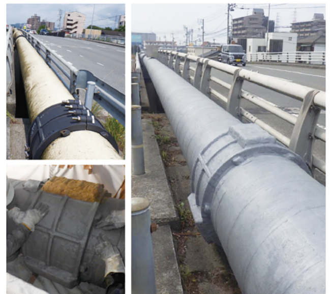
鋼管600A 水管橋70m長 （管体及び漏水補修金具への施工）
